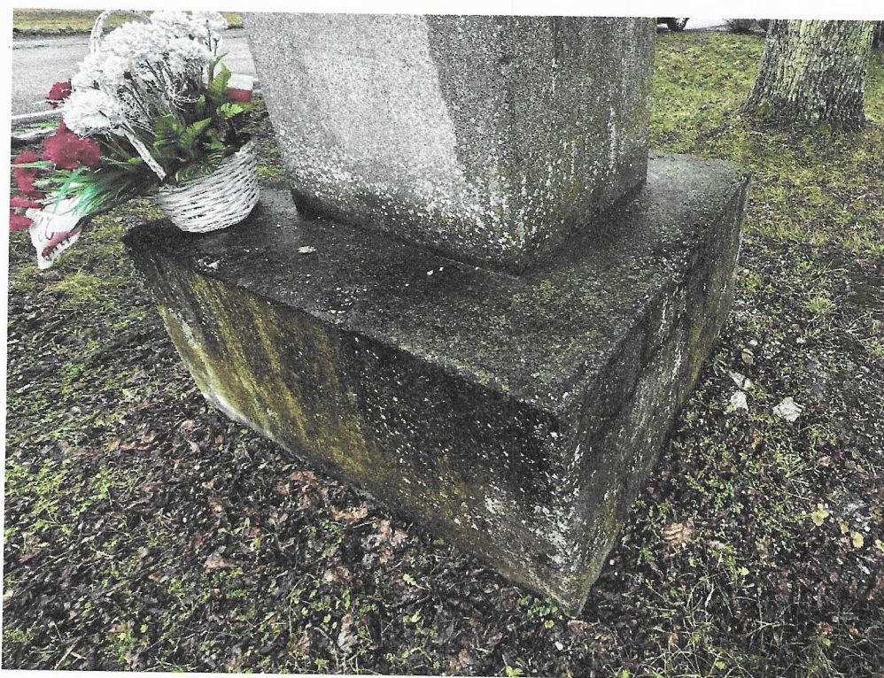
Fot. nr 5 Pomnik Pamięci Piłsudczykom z 1931 roku w Niekrasowie. Widok porażenia mikrobiologicznego na powierzchni cokołu.
