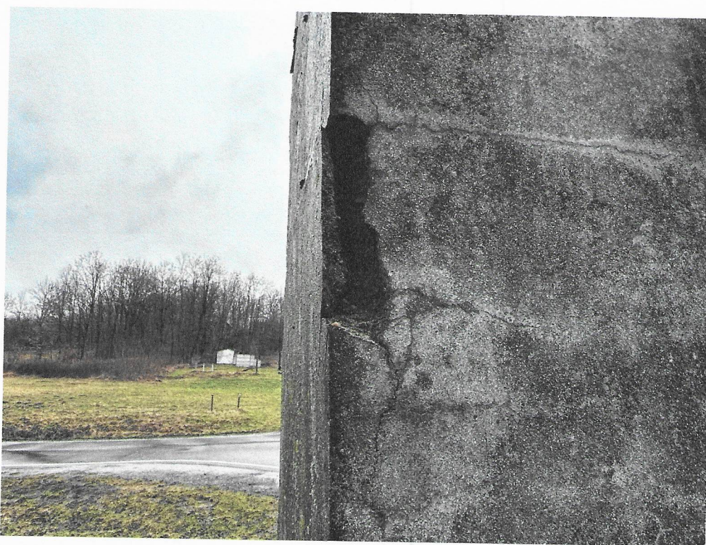
Fot. nr 3 Pomnik Pamięci Piłsudczykom z 1931 roku w Niekrasowie. Widok ubytku warstwy lastryko na krawędzi obiektu.
