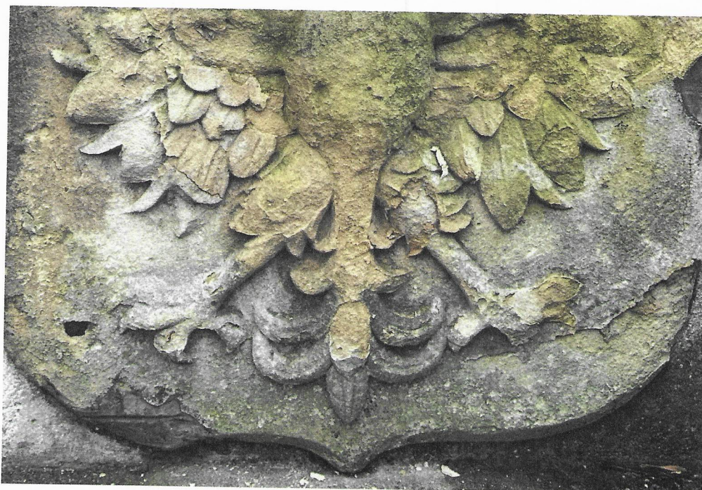
Fot. nr 6 Pomnik Pamięci Piłsudczykom z 1931 roku w Niekrasowie. Widok poważnych uszkodzeń formy rzeźbiarskiej płaskorzeźbionego Orła Polskiego w Koronie.
